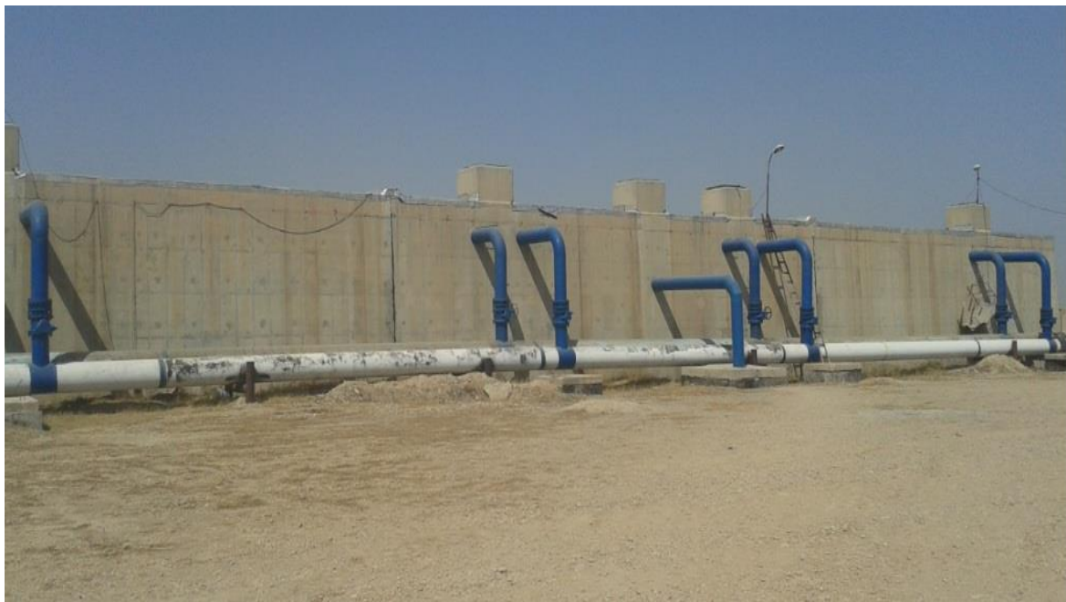
شکل ۴- نمونه ای از مخازن نمایان اجرا شده - تأسیسات شهر بهبهان
