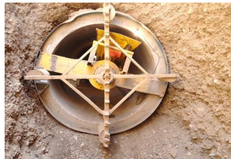
شکل ۲- دستگاه حفار لوله رانی و سیستم جک در غلاف گذاری
