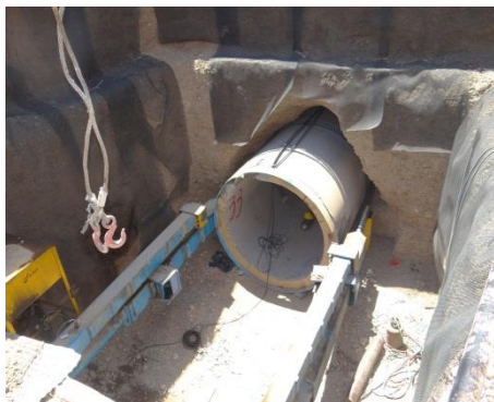
شکل ۲- دستگاه حفار لوله رانی و سیستم جک در غلاف گذاری
