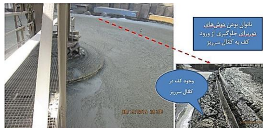
شکل ۱- وجود کف روی سطح تیکنر و کارایی نامناسب دوش‌های کف‌شکن برای مانع شده از راه‌یابی کف به کانال سرریز
