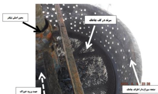
شکل ۳- چاهک خوراک دهی قدیمی تیکنر فاز ۱ تغلیظ ۲ مجتمع مس سرچشمه
