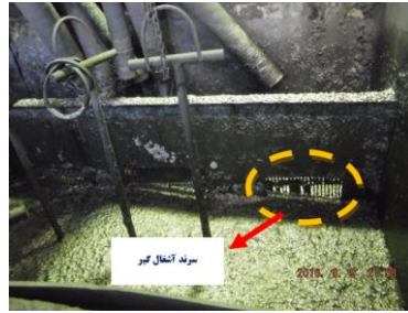
شکل ۶- نصب سردآب آشغال گیر در ورودی تیکنرهای مس-مولبیدن
