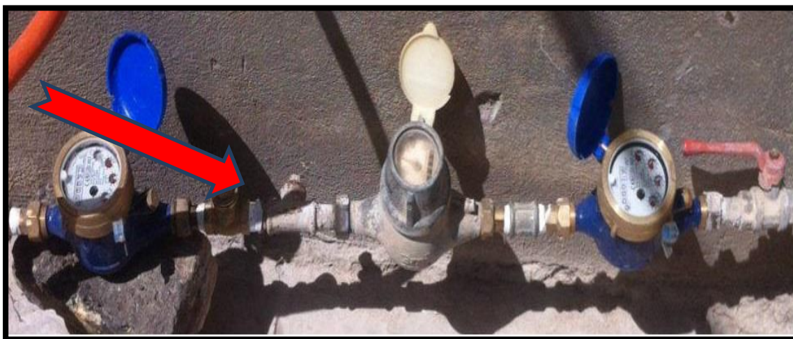
شکل ۴- نصب کنتورهای جدید و قدیم به صورت سری
