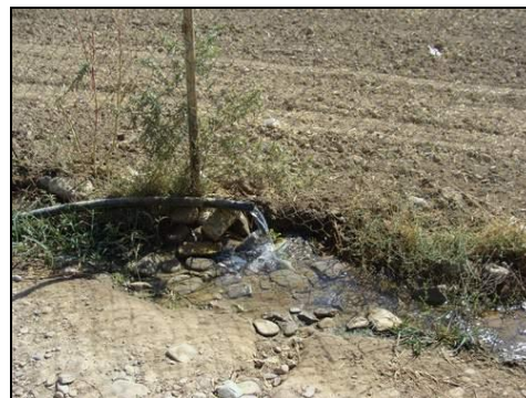
شکل ۵- محل تخلیه پساب شور خروجی از سیستم نمکزدایی از آب (تخلیه مستقیم در اراضی)
