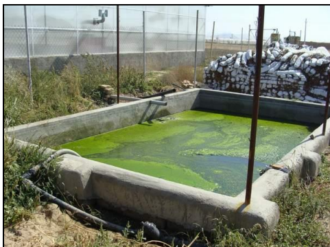
شکل ۶- حوضچه جمع آوری آب مازاد بسترهای کشت، ناشی از آبیاری در داخل گلخانه
