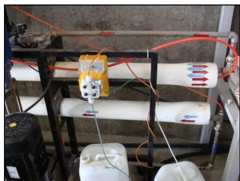
شکل ۴- مسیر جریان آب در صافی‌های سیستم نمک‌زدایی نصب شده در محل گلخانه
